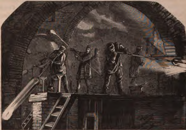
Fig. 252. — Intérieur d'un atelier de soufflage du verre.
